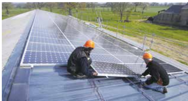
Pose de panneaux photovoltaïques sur un bâtiment agricole.
