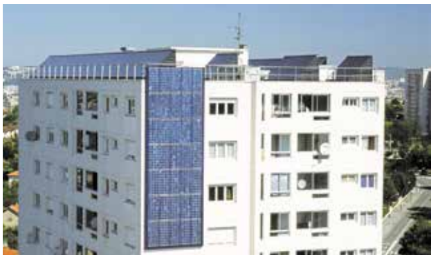
Cet immeuble de l'OPH du Grand Lyon est doté de capteurs photovoltaïques en pignon et de capteurs solaires thermiques en toiture.
